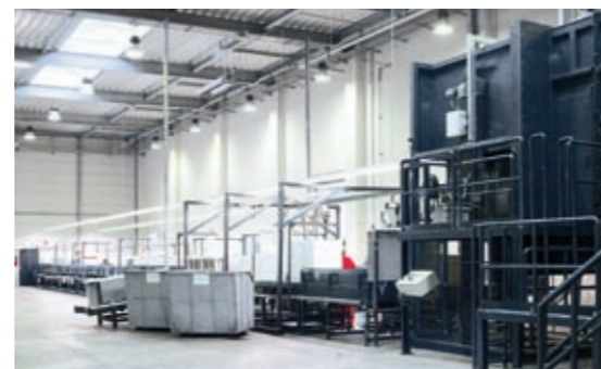
Préparation des appareils de réfrigération
