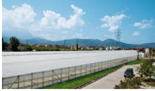
Fethiye'de her yıl güneş ışığının doğal kaynağı aracılığıyla toplamda 12.000 tonluk arıtma çamuru kurutulmaktadır
