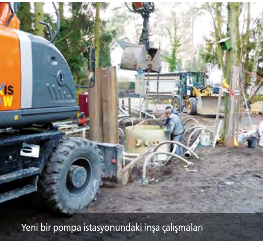
Pompa istasyonları yer altında kuruldu
