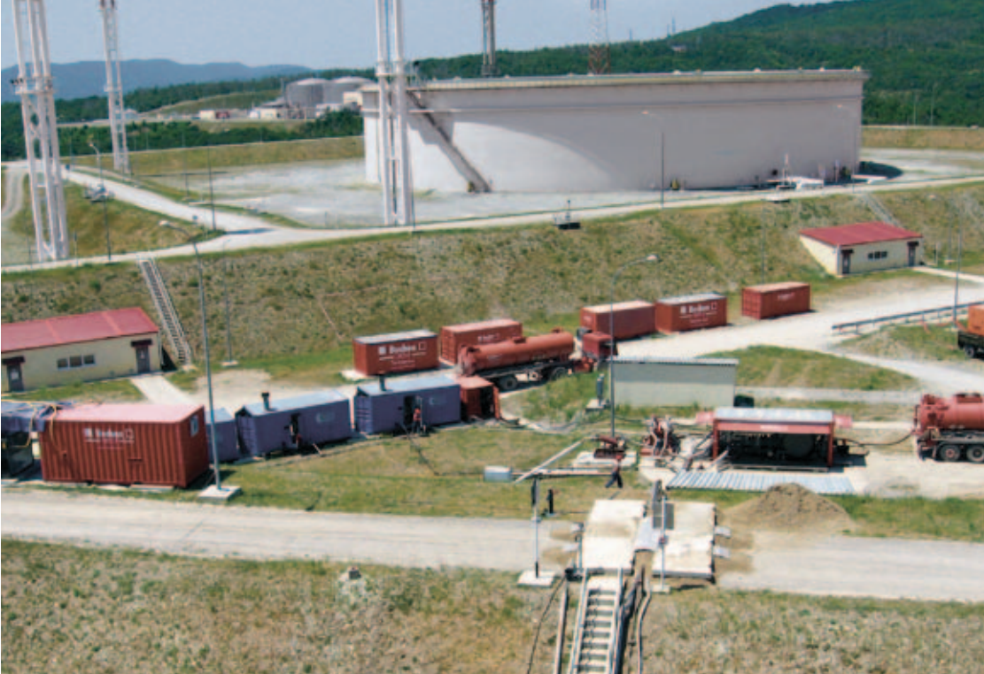
Novorossiysk'teki depolama tesisindeki temizlenecek yüzer ta- vanlı depodaki otomatik Buchen depo temizleme sistemi
