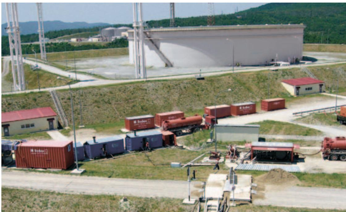
Автоматизированная очищающая установка от Buchen на резервуаре с плавающей крышей в новороссийском нефтехранилище
