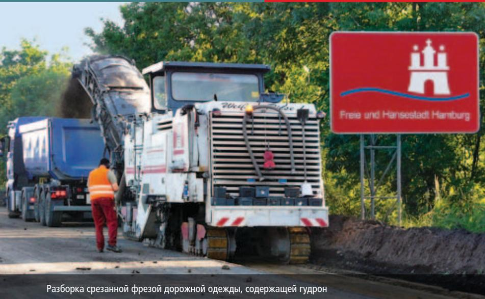
Разборка срезанной фрезой дорожной одежды, содержащей гудрон
