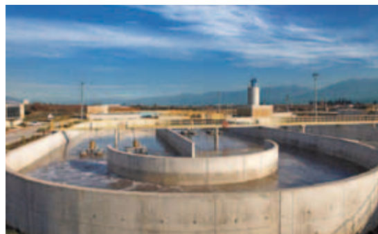
На каждой из своих установок REMONDIS перерабатывает ежедневно до 80 тыс куб.м воды
