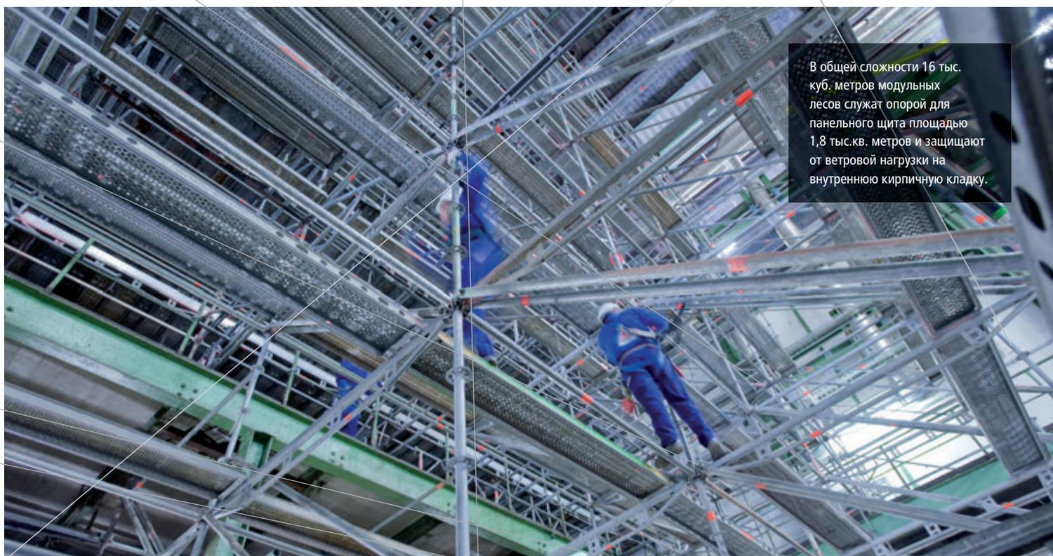
В общей сложности 16 тыс. куб. метров модульных лесов служат опорой для панельного щита площадью 1,8 тыс. кв. метров и защищают от ветровой нагрузки на внутреннюю кирпичную кладку.
