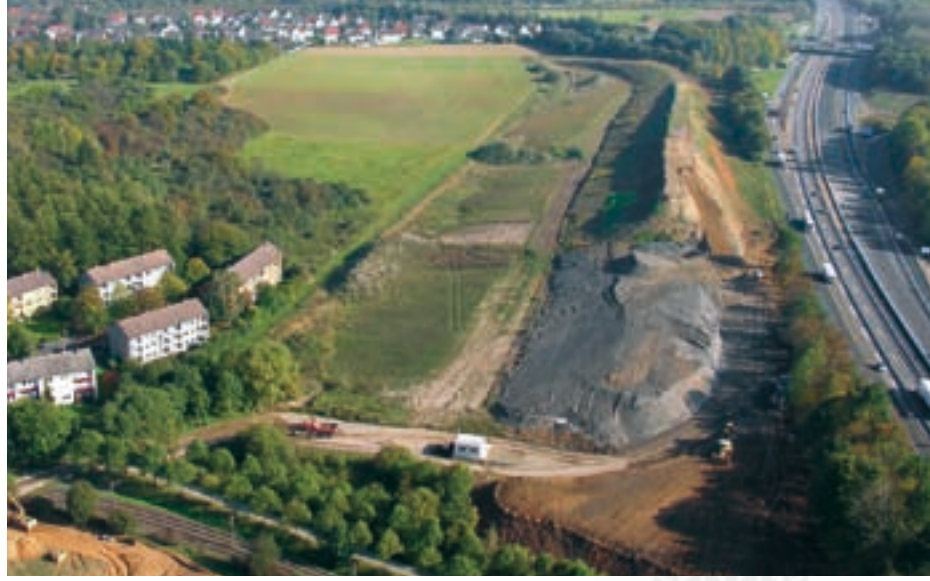
Kassel-Mattenberg'de A44 otopanında inşaat aşamasındaki toprak setinin havadan alınan fotoğrafı
