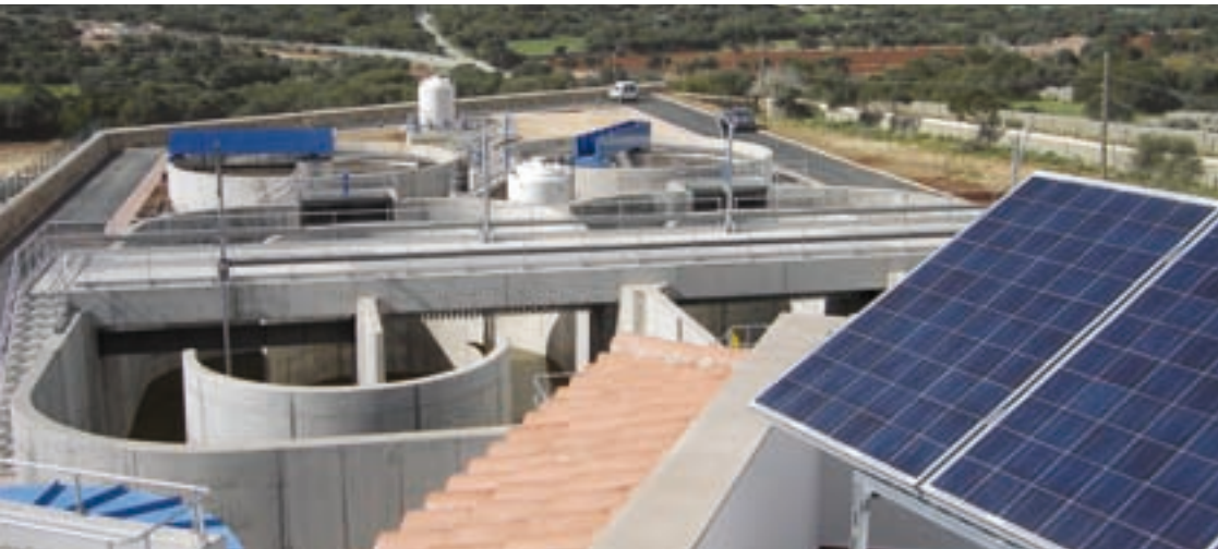
Cal en Porter, OMS'in İspanya'da bulunan modern su arıtma tesislerinden biri
