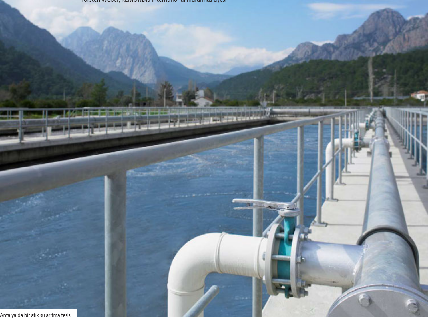
Antalya'da bir atık su arıtma tesis.
